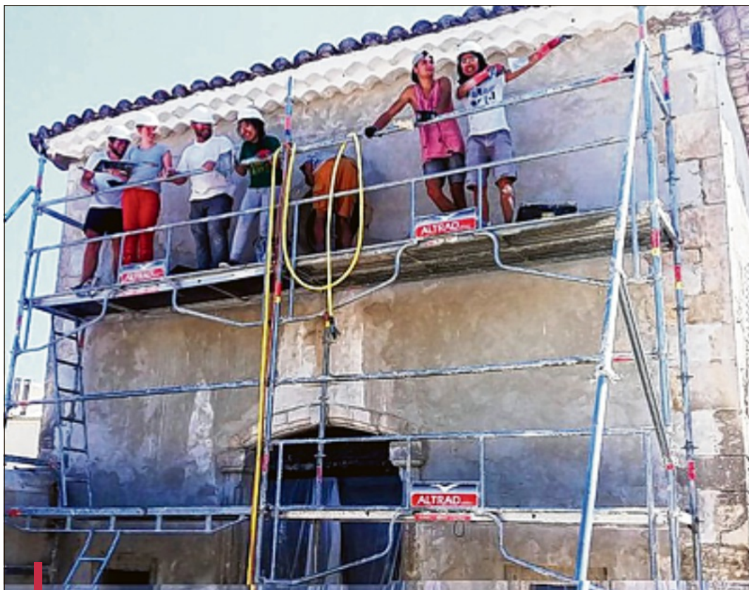
Le but de ce chantier était de restaurer les façades de la chapelle Saint-Michel.
