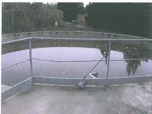
Station d'épuration de NOVES
